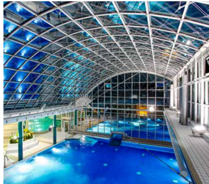
Sie sorgen für eine funktionierende Technik in den Bädern.
